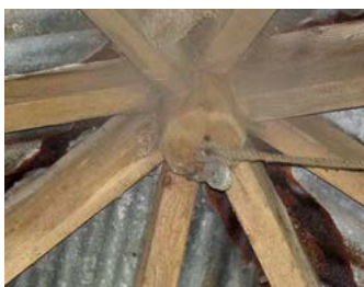
Een katrol boven in de punt voor het opjagen van het hooi, Weelkade Aartswoud.
