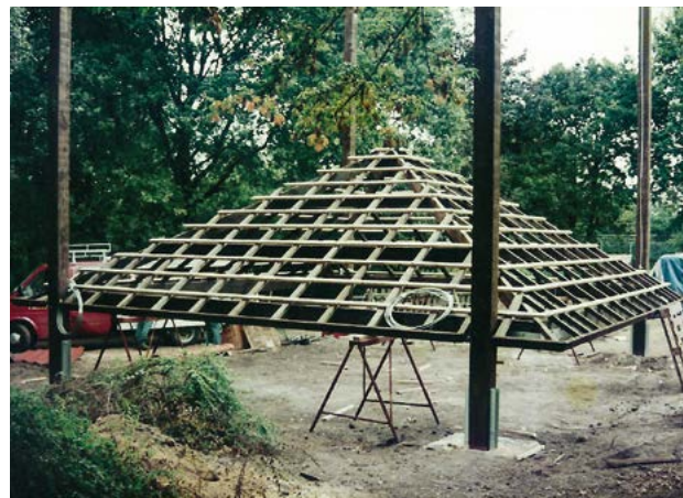
De bouw van het dak van een hooivijzel door de firma Haring. (foto familiearchief)
