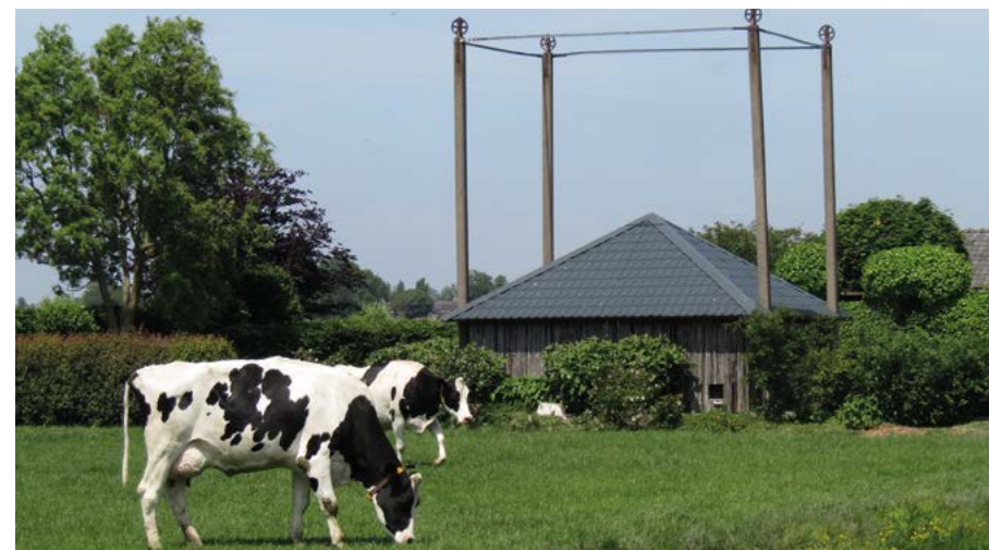
In een hooivijzel zijn de lijnen van een stolpboerderij te herkennen: het piramidedak en de vier staanders. Zoals hier aan de Grootweg in Bobeldijk.
