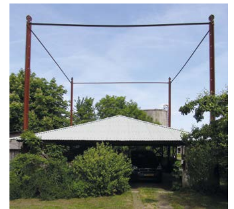
De vijzel van de familie Butzelaar in Grosthuizen is 8 bij 8 meter en 7 meter hoog. Hij is geplaatst in 1957.
