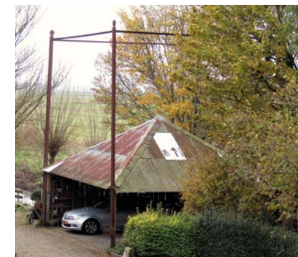
Hooivijzel aan de Westfriesedijk in Aartswoud, met ijzeren staanders en gerepareerd dak van golfplaten.
