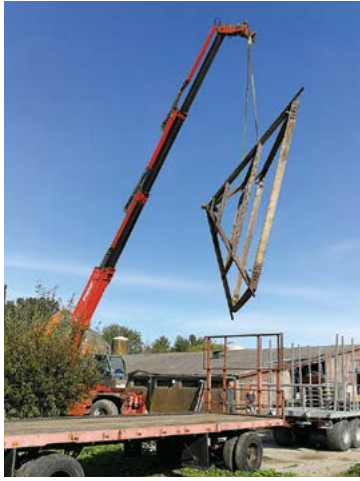
Transport van de Jisperweg in de Beemster naar de Julianastraat in Avenhorn. Het opladen van de houten constructie.
